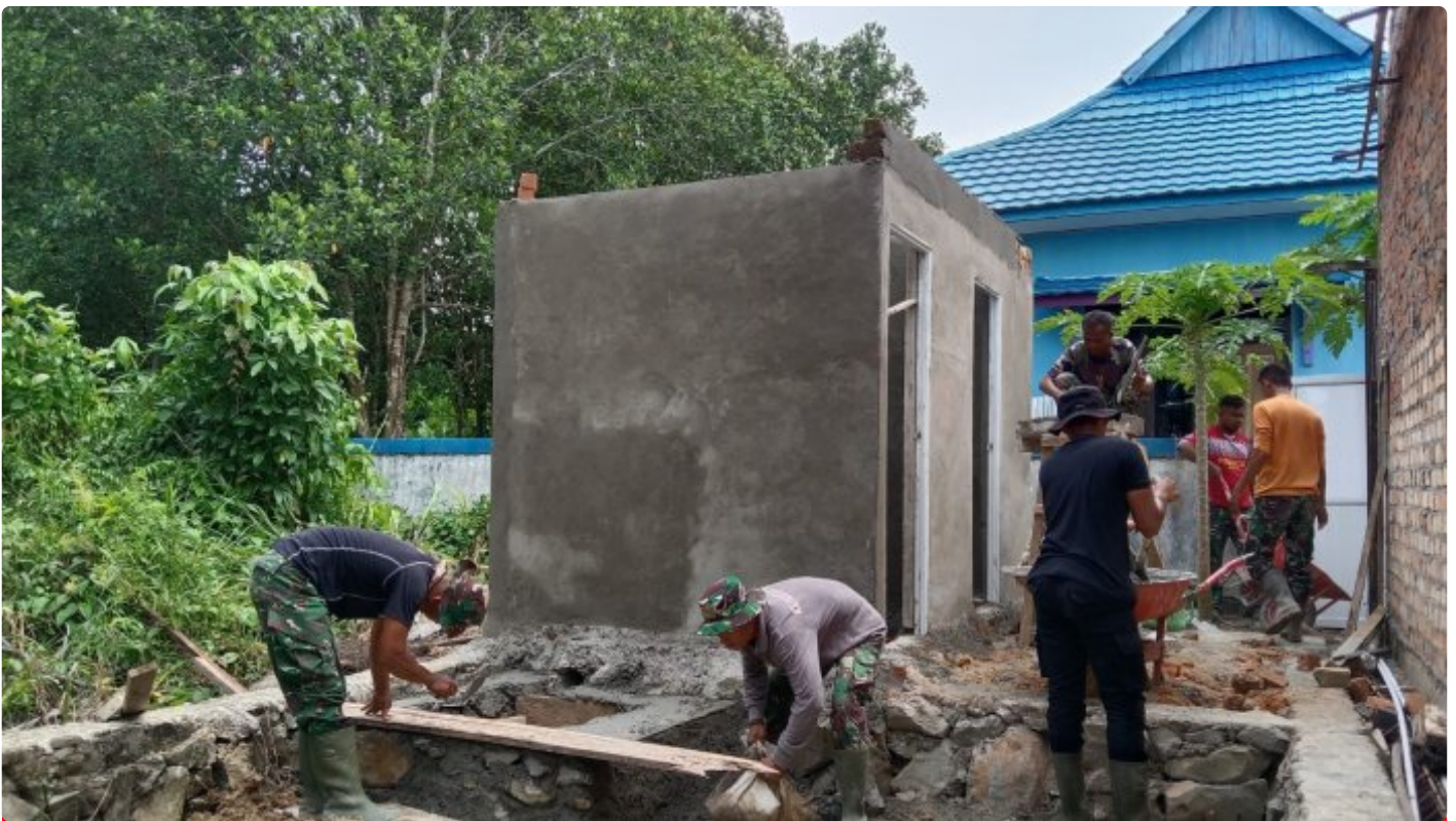
Satgas TMMD ke- 118 Wiltas Kodim 0910/Malinau Progres Pembuatan Septic tank MCK Gereja
