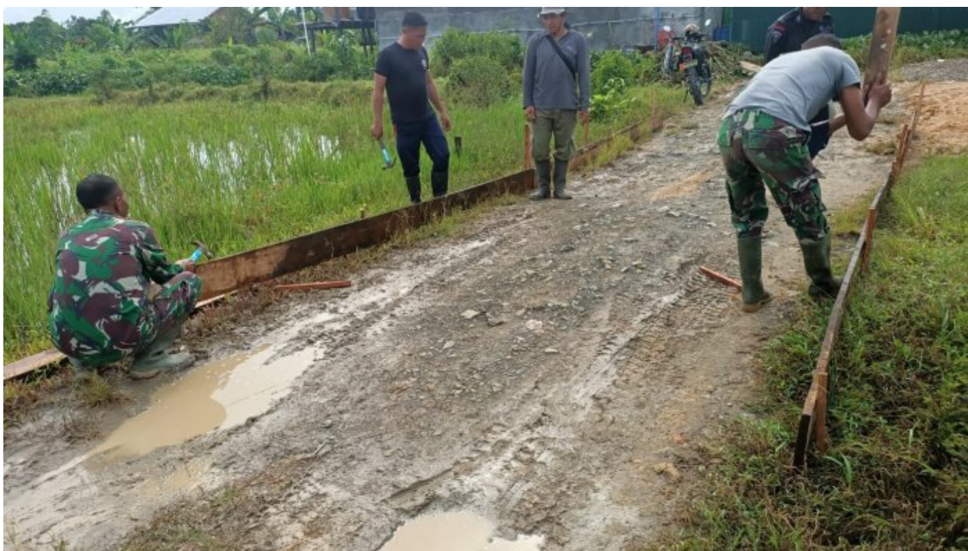
Satgas TMMMD 118 Wiltas Kodim 0910/Malinau Persiapkan Semenisasi Jalan dengan Memasang Mal
