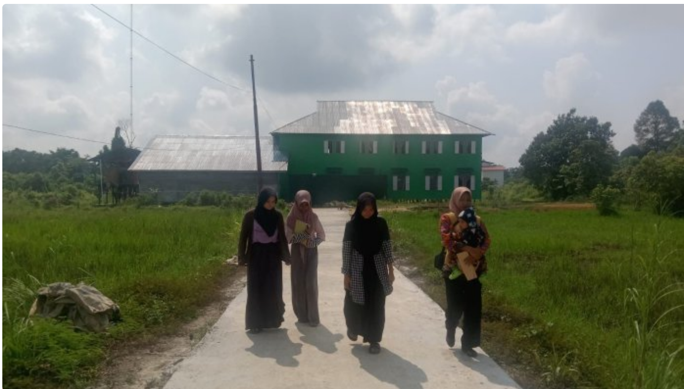
Santriwati dan Warga Sudah Dapat Menikmati Jalan Hasil TMMD Ke-118 Wiltas Kodim 0910/Malinau
