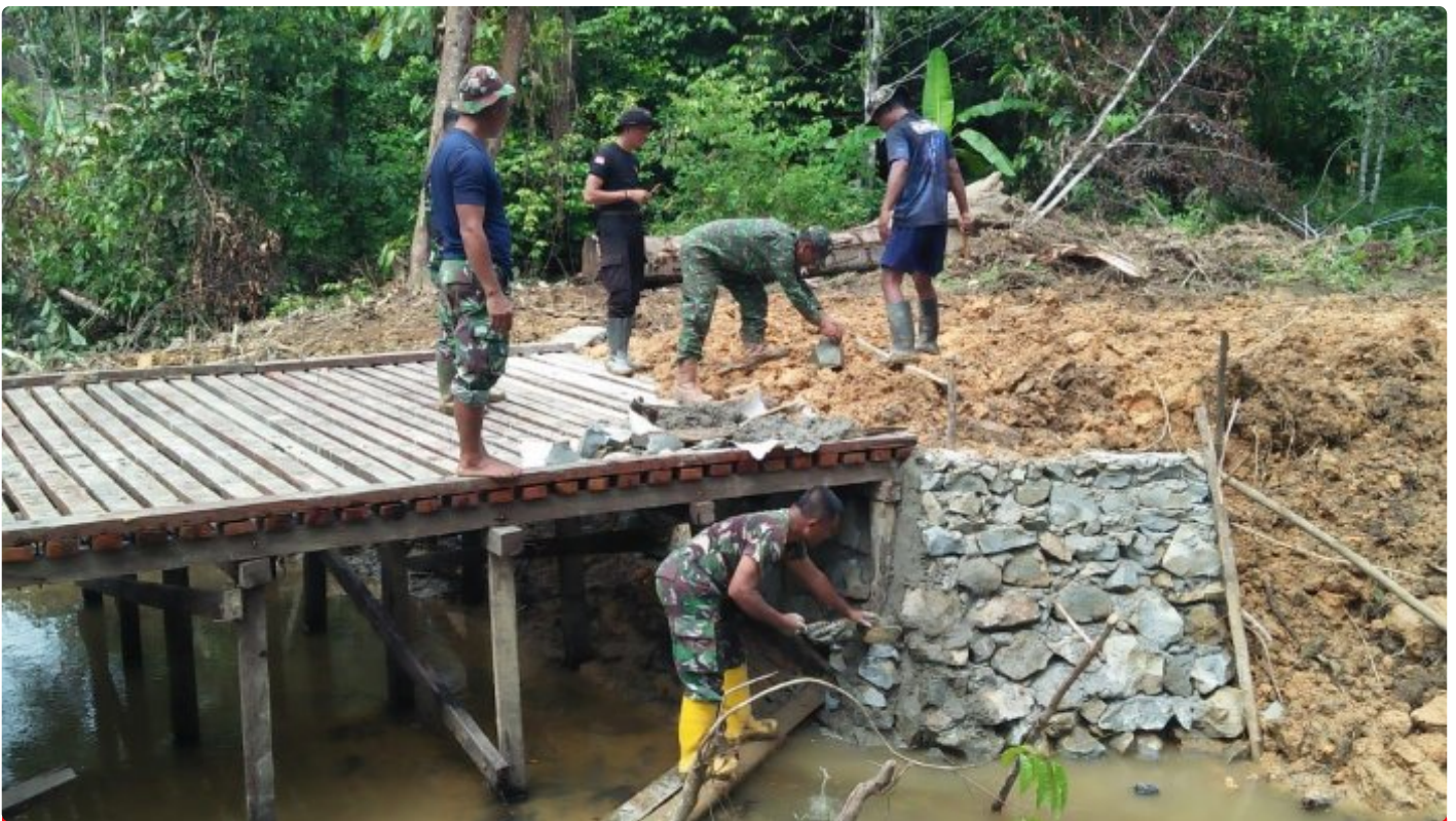
Progres Sasaran Jembatan Kayu Ulin TMMD Ke- 118 Wiltas Kodim/Malinau Capai 75 Persen
