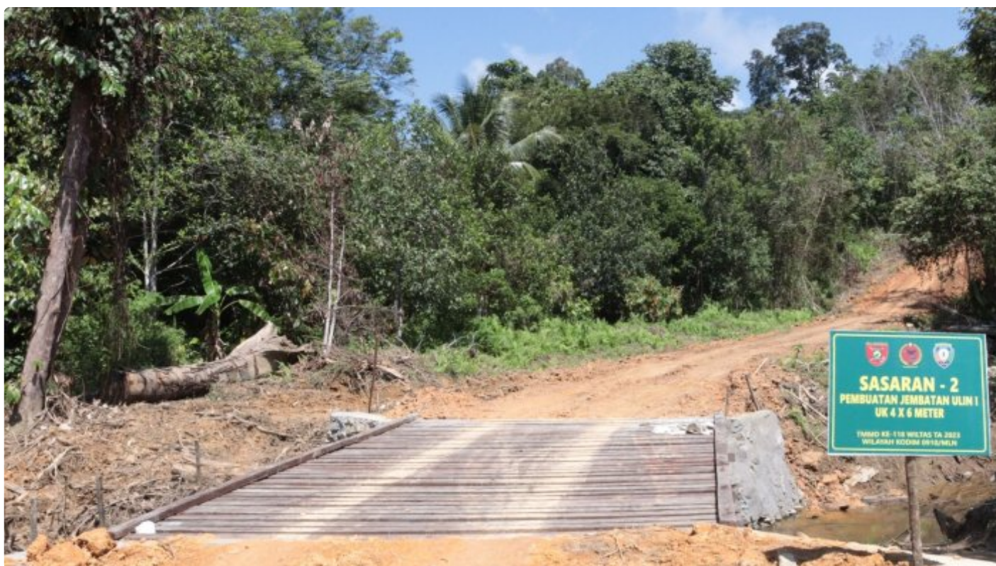
Progres Pembangunan Jembatan TMMD Ke-118 Wilayah Perbatasan Kodim 0910/Malinau Selesai 100 Persen
