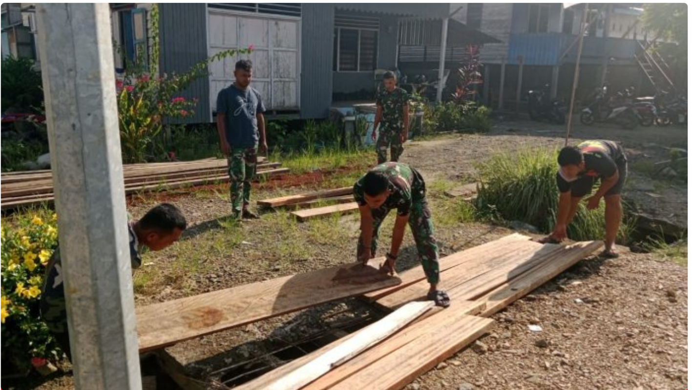
Kehadiran TMMD Ke-118 Wiltas Kodim 0910/Malinau Sangat Bermanfaat Bagi Warga
