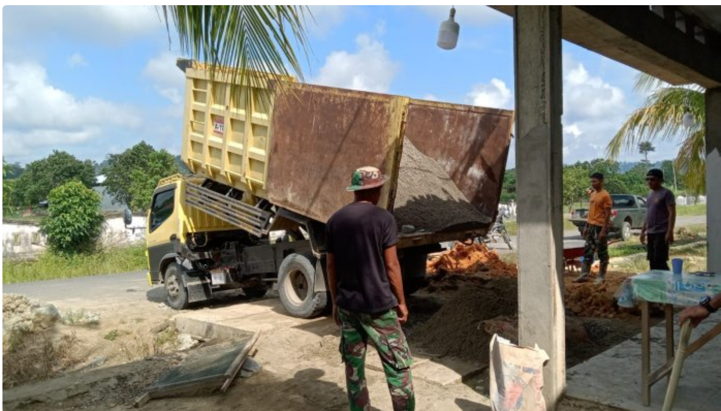
Dropping Material TMMD Ke- 118 Wiltas Kodim 0910/Malinau Terus Dilakukan, agar Pekerjaan Lancar
