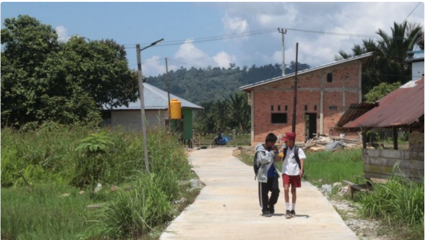
2 Hari Jelang Penutupan TMMD Ke- 118 Sasaran fisik Semenisasi Jalan Selesai 100 Persen
